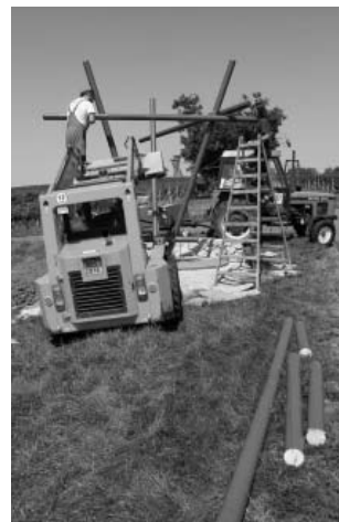
Pod Slunečnou se začíná s montáží konstrukce nového odpočívacího místa.
